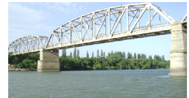
Fotos : Puente Ferrocarretero
