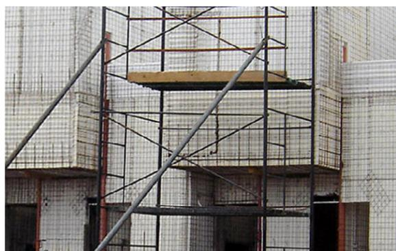
CASSAFORMA reemplaza lo que en la construcción tradicional significa la ejecución de encadenados, estructuras de hormigón armado, sus encofrados y armaduras, mamposterías, dinteles, revoques gruesos, aislaciones horizontales y verticales, simplificando entonces la compleja interacción entre los gremios. Ya desde el presupuesto de obra se evidencian las ventajas, debido a la reducción de elementos que intervienen en la misma.
